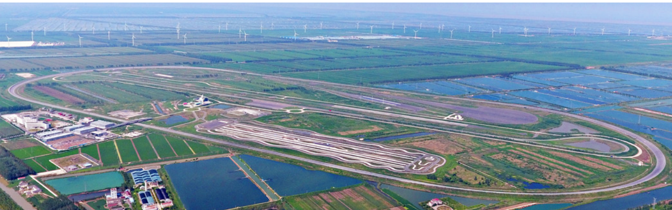
盐城试车场全景
